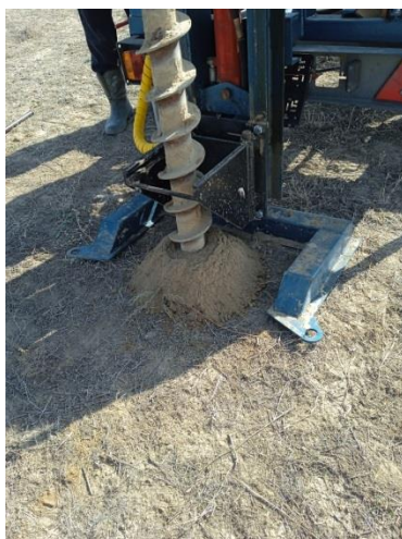
Рисунок 4 - Шурфирование на второй площадке между 2 лунками (экспозиция 48 часа)
